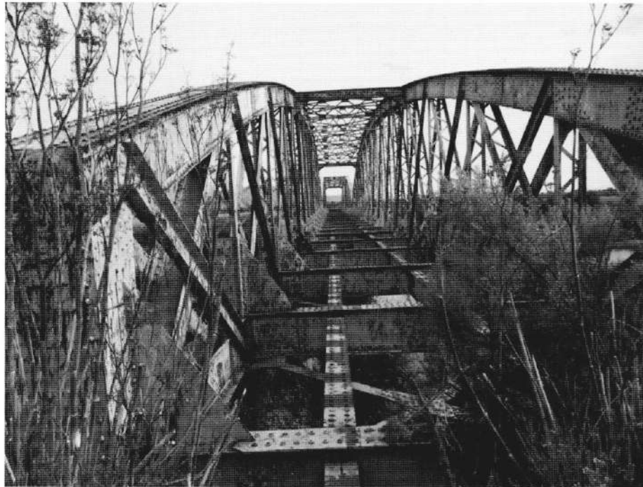
Puente de Perquilauquén, en el ramal ferroviario de Parral a Cauquenes construido por el ingeniero francés Máximo Dorlhiac en 1894. Es monumento nacional desde 1996.
