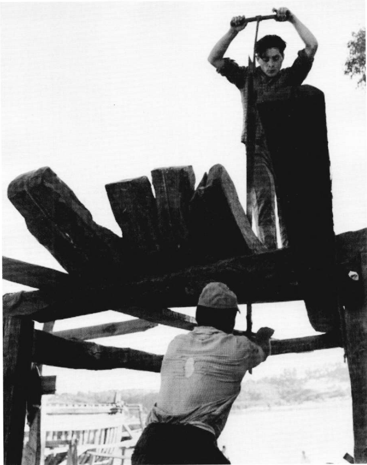
Astilleros cortando las cuadernas de un falucho, con sierra de mano.
