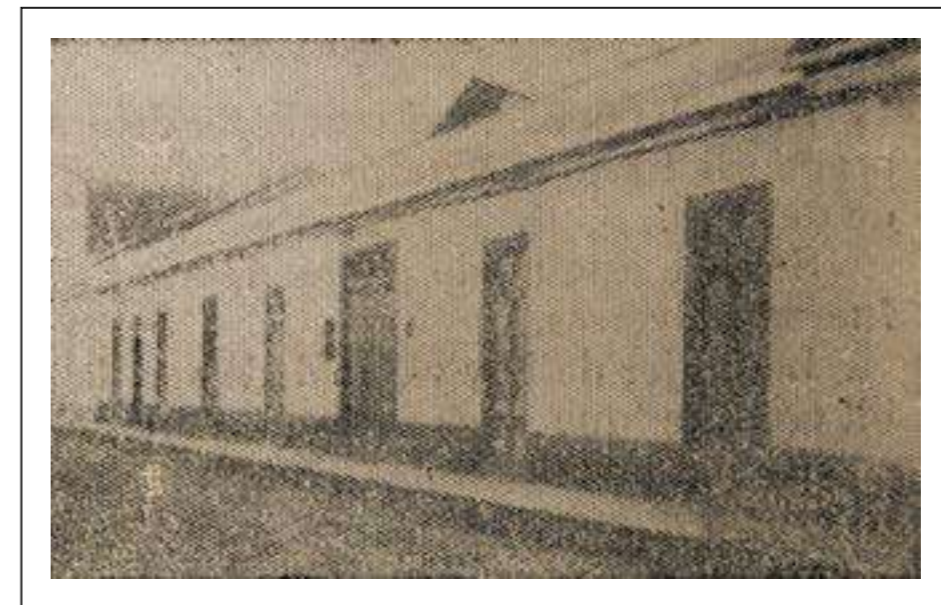
Centro Familiar 12 de octubre, fundado por elementos laboristas de la colonia en 1921, fomentaba el encuentro familiar.
